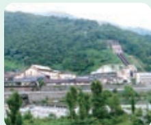
廃バッテリーから有用金属を回収する神岡鉱業所
